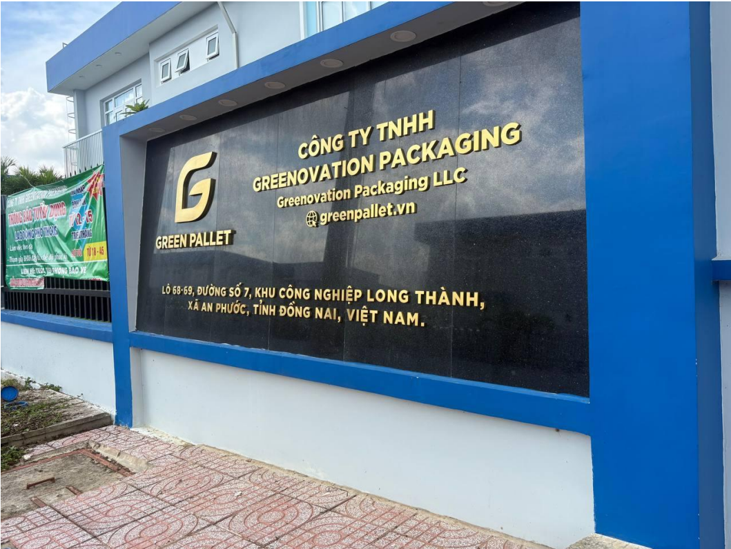
Mặt tiền nhà máy Greenovation Packaging (Green Pallet) với biển hiệu công ty, thuộc KCN Long Thành, Đồng Nai.
